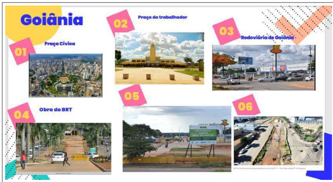
Figura 5: Fotos do Centro de Goiânia e construção do BRT Org.: Elaborado pelas autoras, 2023.
