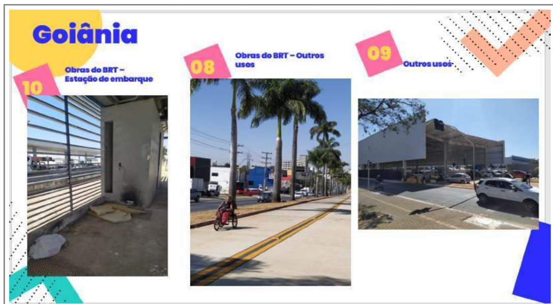
Figura 6: Construção do BRT Org.: Elaborado pelas autoras, 2023.
