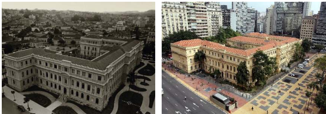
Figura 2: Antiga Escola Estadual Caetano de Campos em São Paulo, edifício construído em 1896. Fotos: acervo.estadao.com.br
